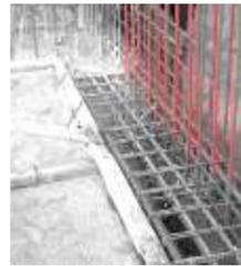
**N°5** Se colocan los estribos para mantener la distancia entre las dos caras del muro y luego se une todo con alambre negro.
